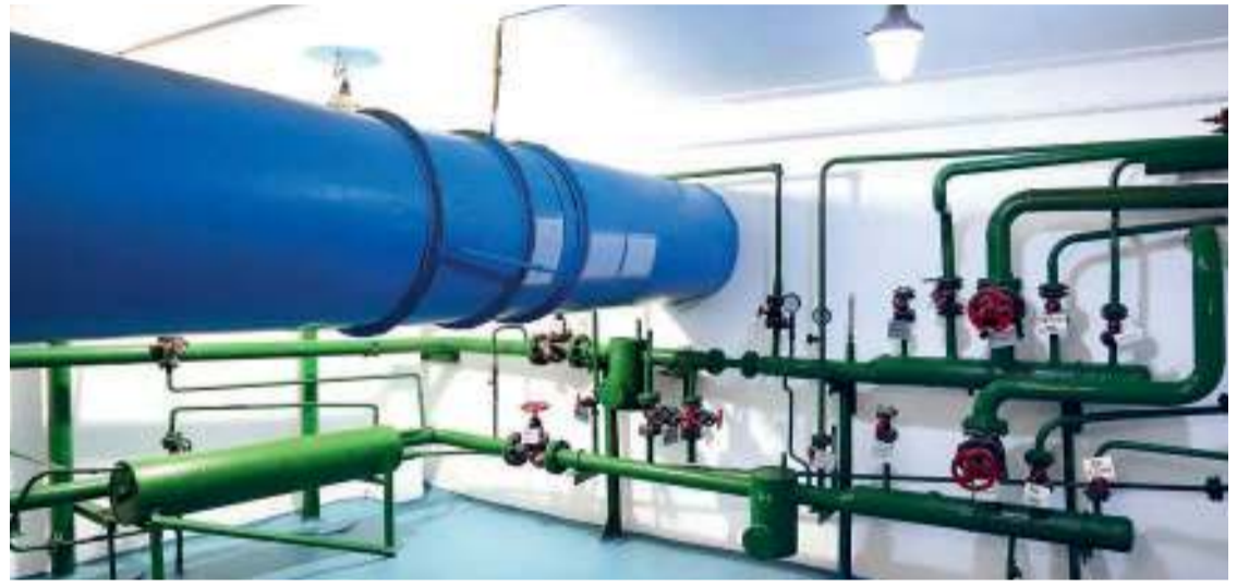
В корпусе №147 отремонтировали теплопункт
